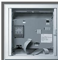
Электрощиток для установки управляющей электроники Instabus для скрытого монтажа
